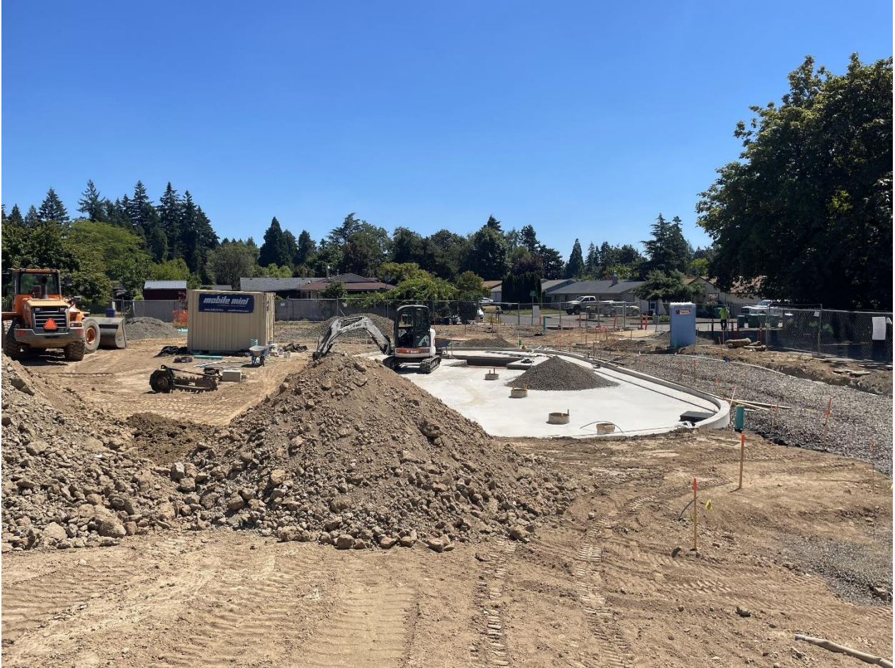
Progress at Bowman-Brae on the future playground / Avances en la futura zona de juegos del parque Bowman-Brae
