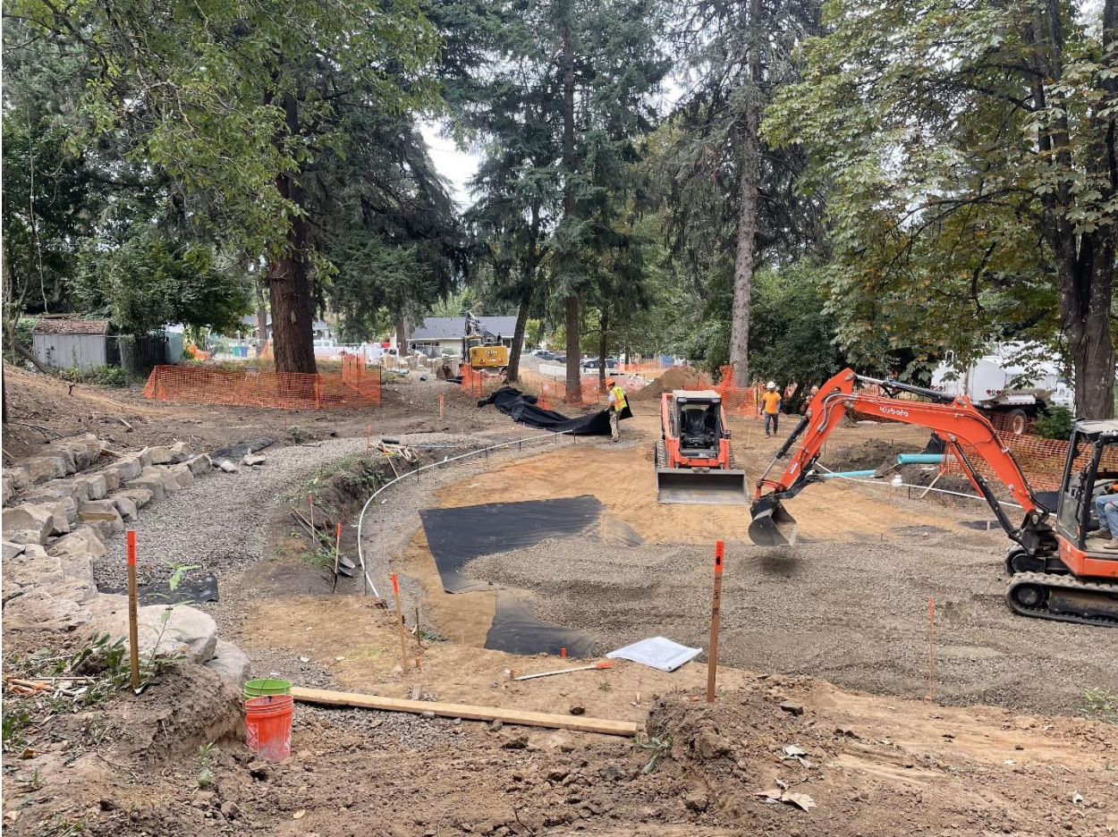
Progress on the rock retaining wall above the future playground at Balfour Park / Avances en el muro de contención de rocas sobre la futura zona de juegos del parque Balfour
