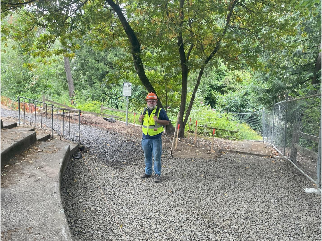
The progress at Scott Park next to the Ledding Library / Avances en el parque Scott, junto a la biblioteca Ledding
